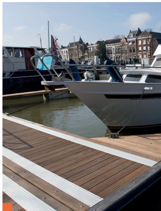
Ein Hartholzbelag sorgt für eine stabile und klassische Oberfläche mit warmer, maritimer Ausstrahlung. Das Hartholzdeck ist von hoher Qualität und hat eine lange Lebensdauer. Die speziell von Inter Boat Marinas entworfene Profilierung ist relativ flach, wodurch die Decksteile schneller trocknen und Schmutz in deutlich geringerem Maße zurückbleibt.
