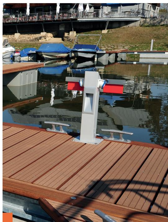
**Für unsere Schwimmstegsysteme verwenden wir verschiedene Schwimmkörpertypen: Beton-, Kunststoff- und Rohrschwimmer. Welche Schwimmkörper zum Einsatz kommen, hängt vom Steg und den an ihn gestellten Anforderungen ab. Im Allgemeinen werden Betonschwimmer für Hauptstege und Pontons und Kunststoff- oder Rohrschwimmer für kleinere Stege und Ausleger verwendet.**
